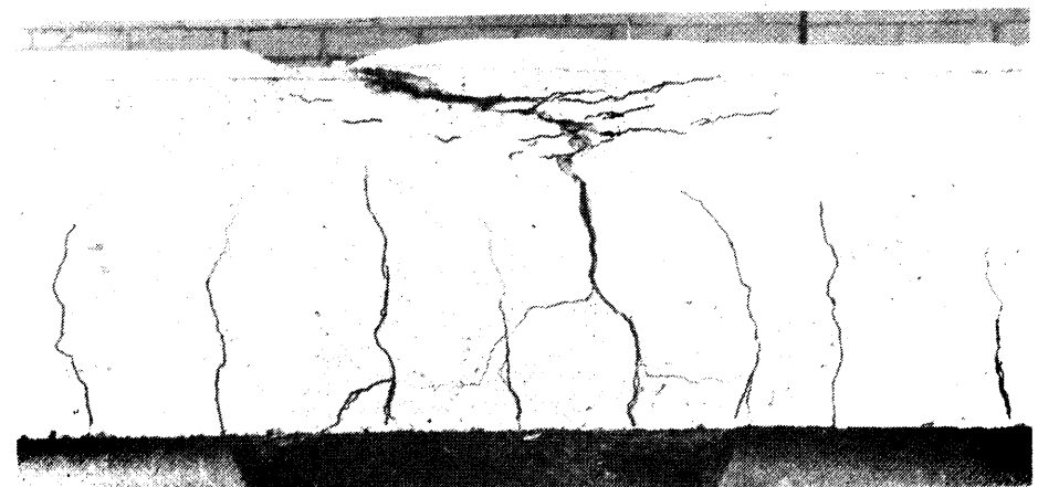
Foto 26 Foto yang lebih rinci mengenai balok yang mengalami retak lentur yang diperlihatkan pada Foto 25.
