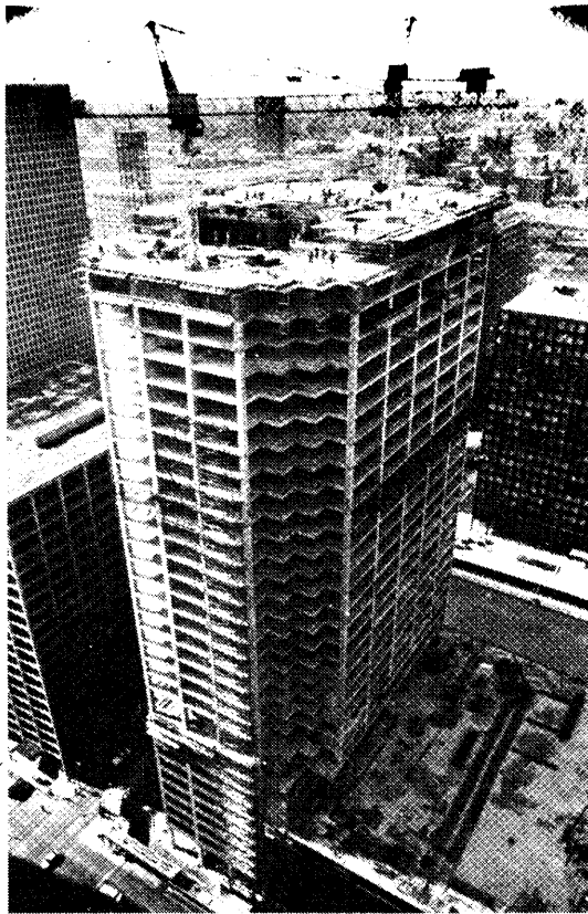
Foto 70 Chicago Mercantile Exchange: Menara perkantoran kantilever dari beton bermutu tinggi. (Atas izin Robert B. Johnson, Alfred Research and Co., Chicago.)
